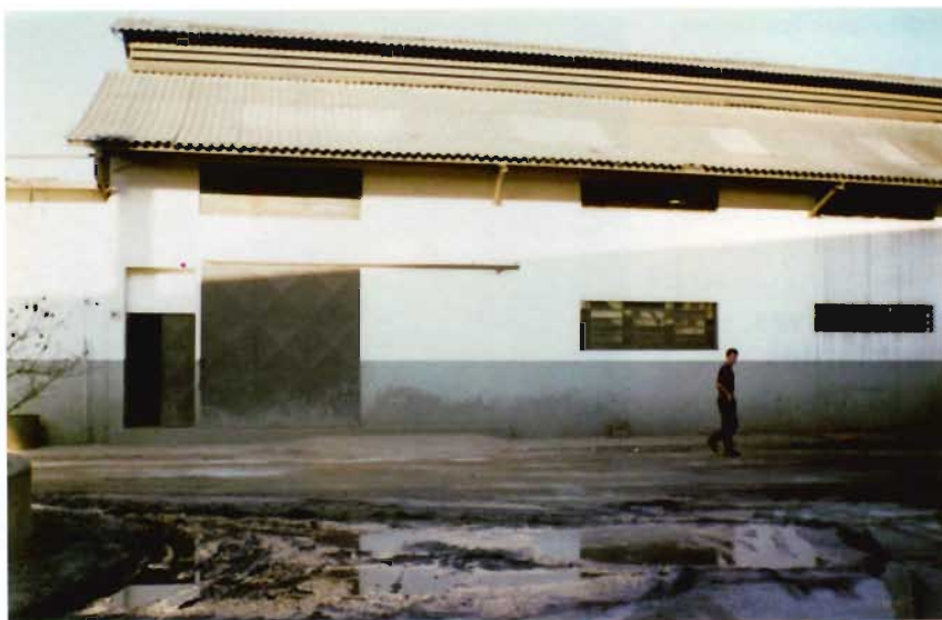
Foto 6: Vestiário construído com 4 mil blocos de concreto de agregado reciclado. Usina de asfalto, São Paulo, Brasil
