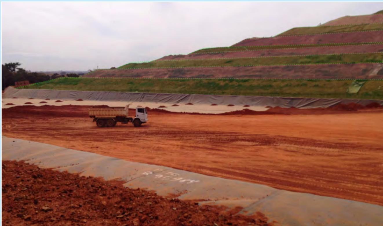
Foto 1. Ilustração do empilhamento de camadas de resíduos Classe II, em aterro sanitário (Fonte: Acervo Geotech).
