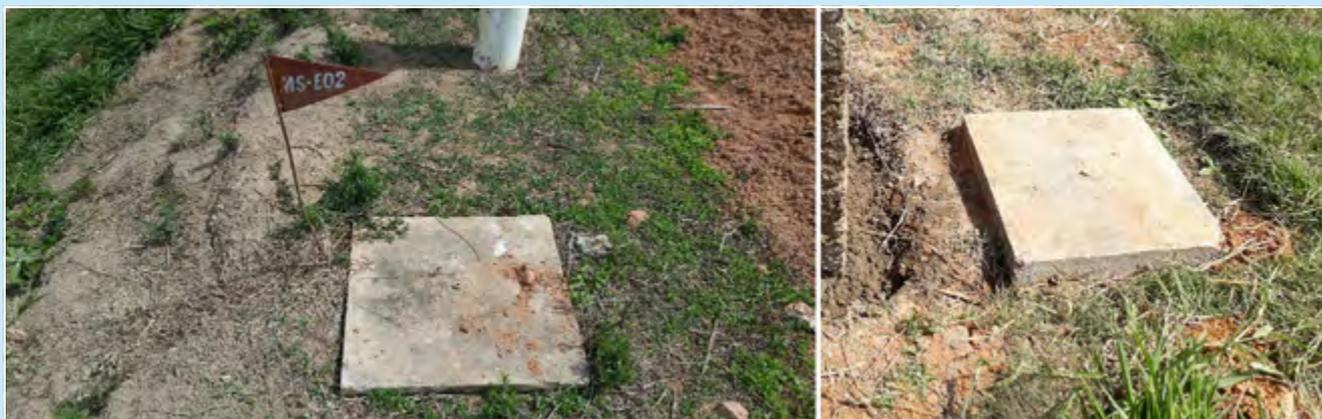
Foto 3. Marcos superficiais implantados na crista do talude de Aterros sanitários (acervo Geotech).
