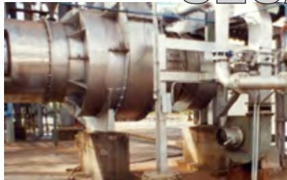
Sistemas Flash Dryer integrado com Duct Burner para secagem de lodos-lamas com até 30% de umidade.
