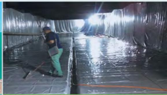
REVESTIMENTOS PARA CAIXAS D'ÁGUA
