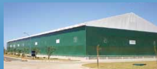
Galpão estruturado para confinamento de resíduos perigosos.
