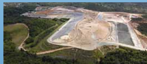
Cobertura de Aterro Sanitário / Salvador - BA
