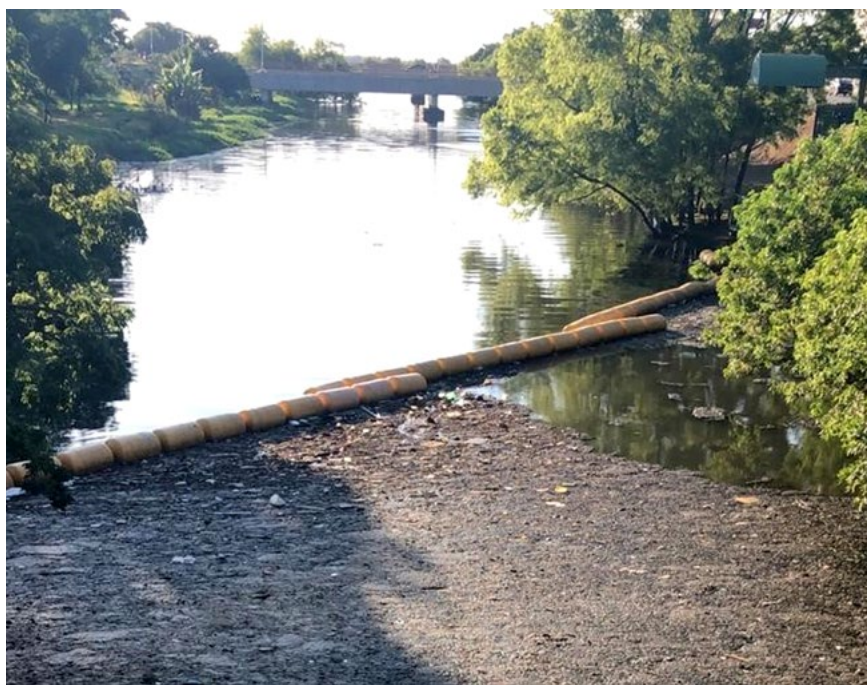
A ecobarreira instalada no Arroio Dilúvio, em Porto Alegre, reteve mais de 700 toneladas de resíduos flutuantes
