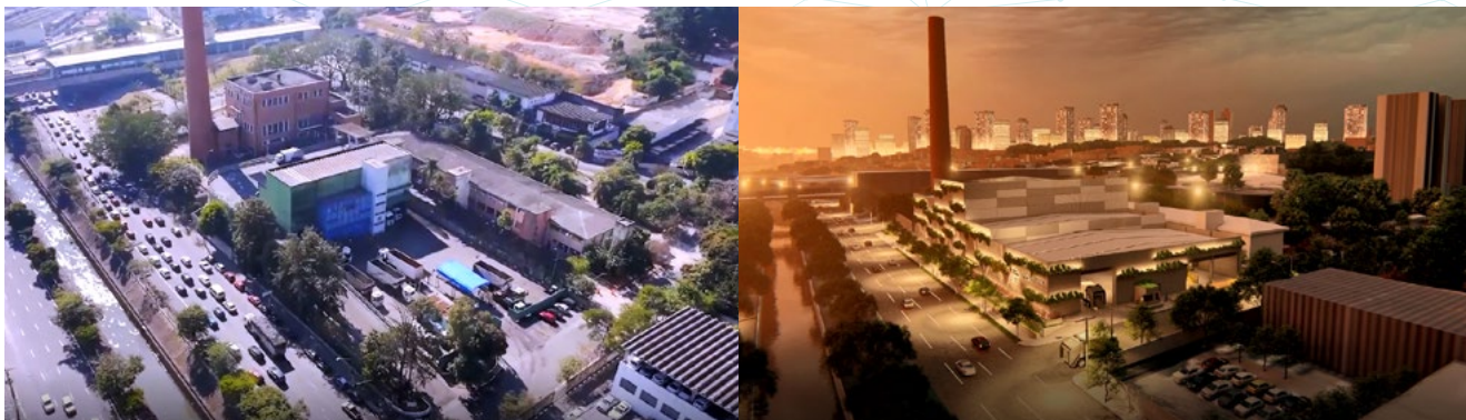
Antes e depois: imagem aérea da Estação de Transferência Vergueiro
