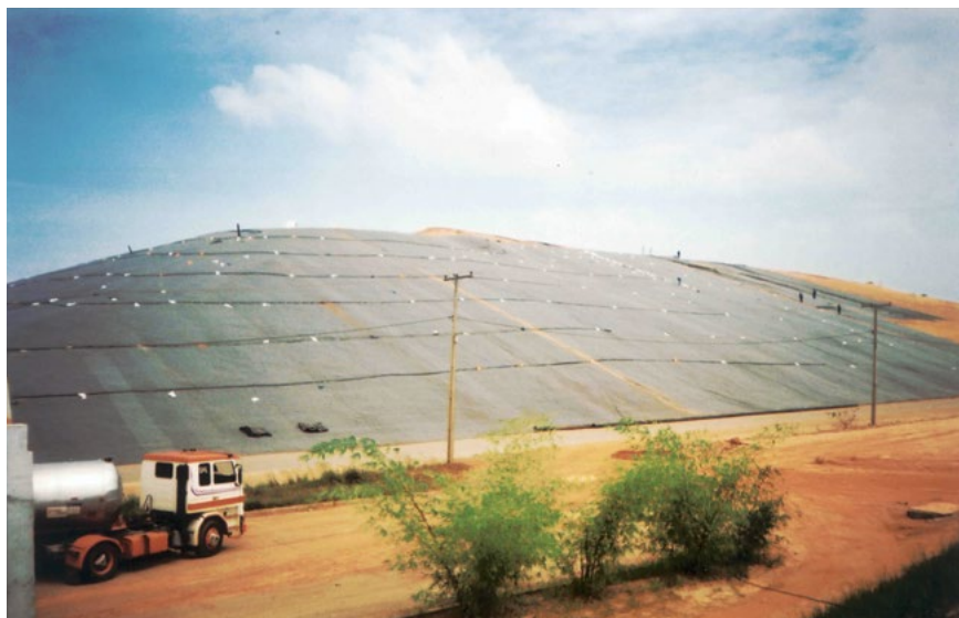
Cobertura de aterro sanitário
