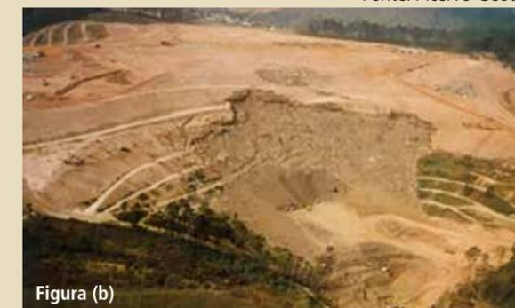
Figura 5.2. (a) Situação antes da ruptura do AS Bandeirantes, (b) Situação pós-rompimento (L/H =3).
