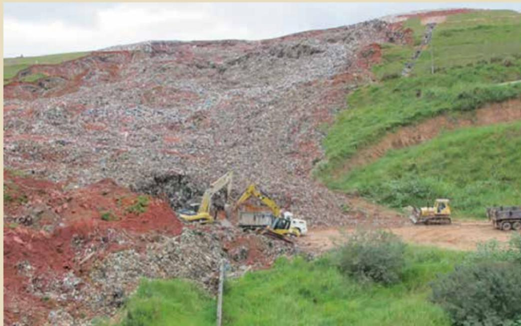
Figura 5 8. Ruptura do maciço de resíduos do AS Itaquaquetuba, SP (L/H=4).
