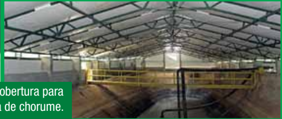
Cobertura estruturada para confinamento de resíduos perigosos.
