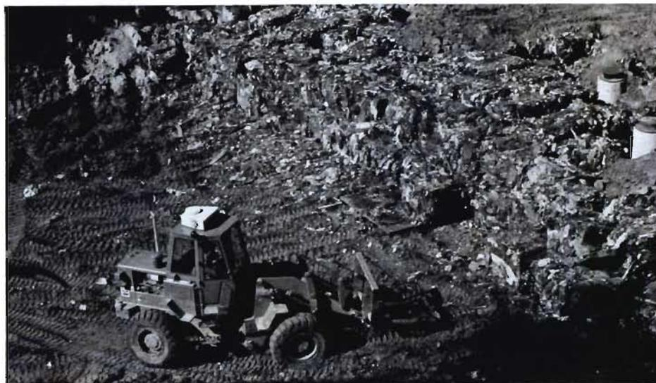
*Formação do aterro com lixo enfardado, vendo-se o dreno conjunto de líquidos e gases e os poços de visita das linhas de esgoto de águas pluviais, protegidos com areia.*
