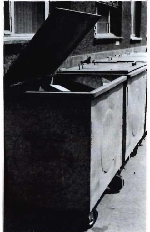
*Containers utilizados para o acondicionamento de lixo, quando a produção excede mil litros.*
