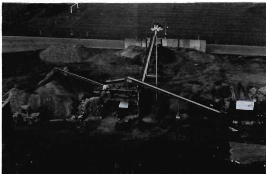
*Equipamento de seleção da escória para separação de metálicos e material para agregado do incinerador Sudeste de Hamburgo, cuja entrada em serviço deu-se em 1973.*
