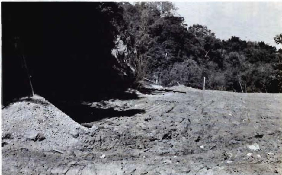
*Detalhe dos drenos conjuntos, de líquidos e gases, de tubos de polietileno de 4", revestidos de pedra britada, junto às paredes do canion. Aterro de lixo enfardado de Omaha, Nebraska, EUA.*
