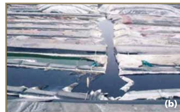
**Figura 1.** Exemplos de falhas devido à ausência de CQC e GQC: (a) Lagoa de irrigação com geomembrana de PEAD problemática devido à instalação sem CQC e GQC. Custo dos services de CQC e GQC: dezenas de milhares de dólares. Custo de reparo: US\$ 1.3 milhões de dólares. (b) Digestor anaeróbio com colapso do sistema de impermeabilização construído sem um programa de GQC e revisão do projeto. Custo dos services de GQC e revisão: US\$ 40 mil. Custo de reparos: > US\$ 21 milhões.
