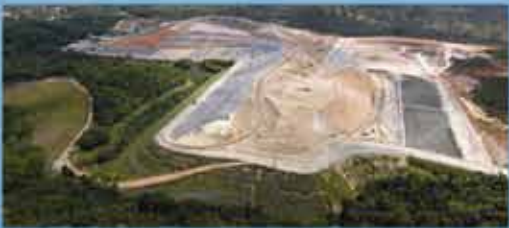
Cobertura de Aterro Sanitário / Salvador - BA
