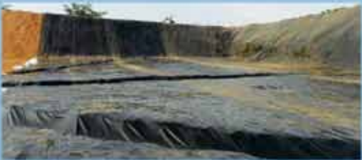
Base de Aterro Sanitário / Brejo Santo – CE
