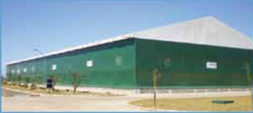
Galpão estruturado para confinamento de resíduos perigosos
