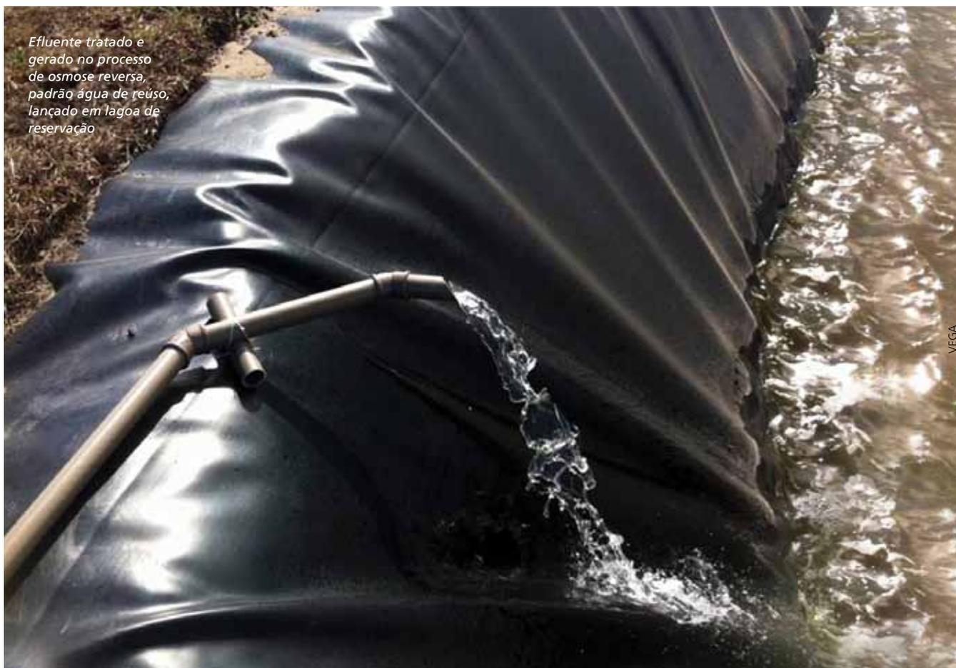
*Efluente tratado e gerado no processo de osmose reversa, padrão água de reúso, lançado em lagoa de reservação*
