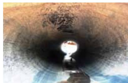
Tubulações de concreto e tubo N12 corrugado de PEAD submetidas a cargas de caminhões e recalques do aterro.
