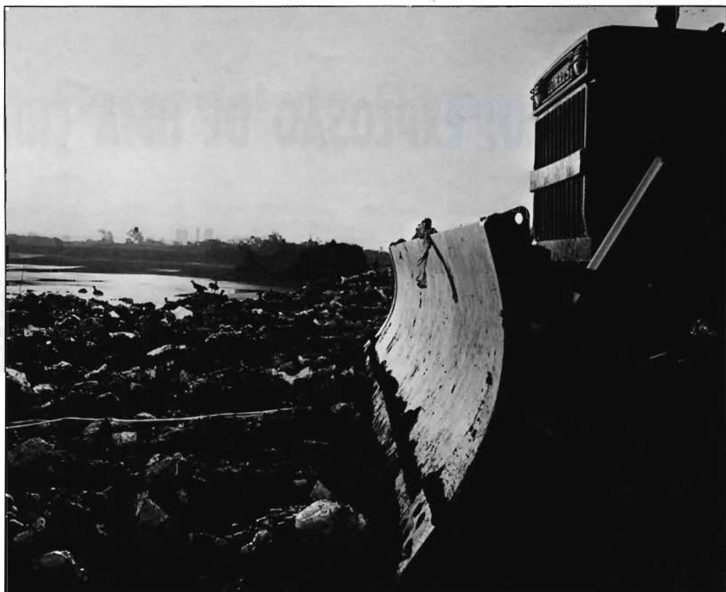
Aterro sanitário de Engenheiro Goulart.
