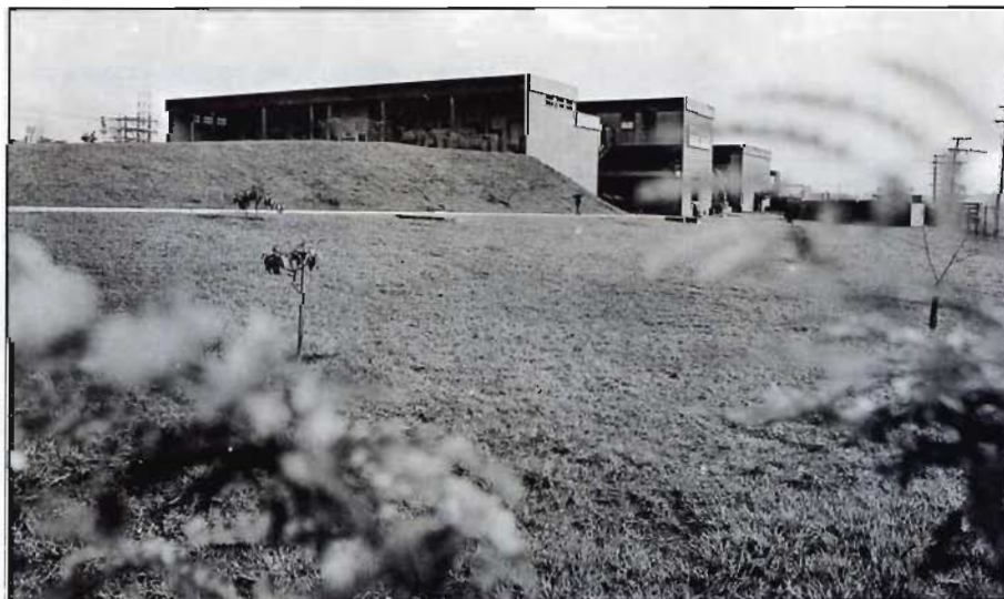
Usina de S. Mateus: vista externa.
