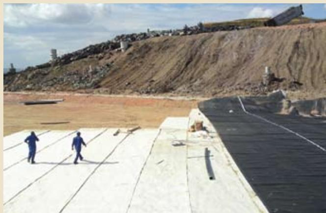
taludes; poder de auto-cicatrização que possibilita a selagem de um eventual dano pouco tempo após a sua ocorrência; possibilidade de instalação em épocas de elevado índice pluviométrico; baixo custo aliado à facilidade de instalação do produto.
