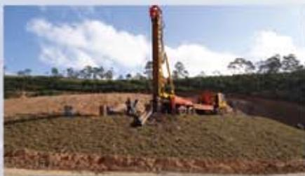
Serviços desempenhados com escavações mecanizadas com Trado Helicoidal a Seco.
