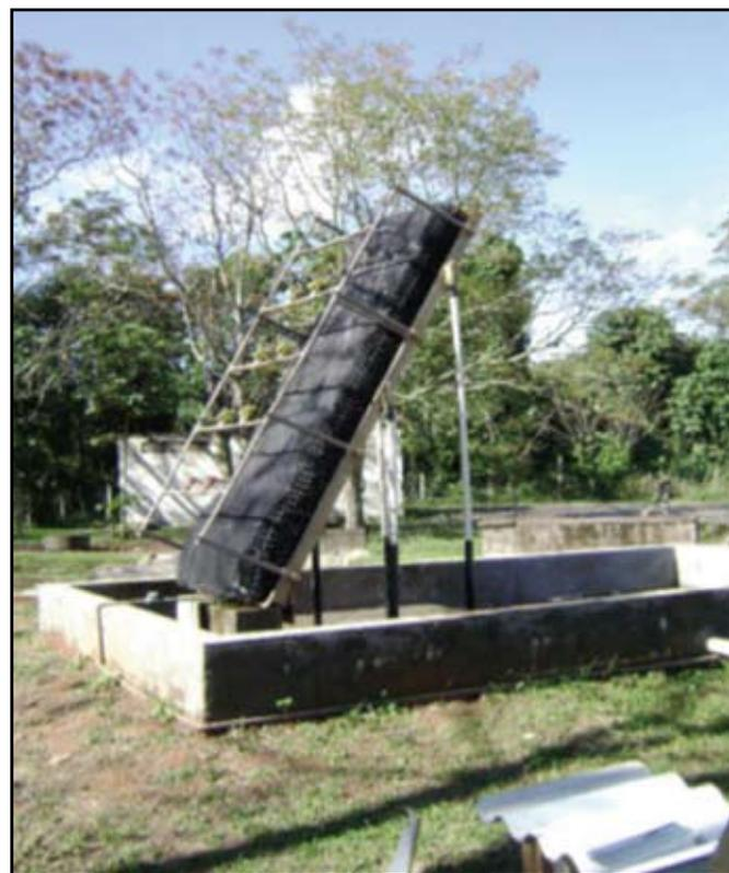
Figura 4 - Ponto de coleta no sistema de tratamento de lixiviados por evaporação natural
