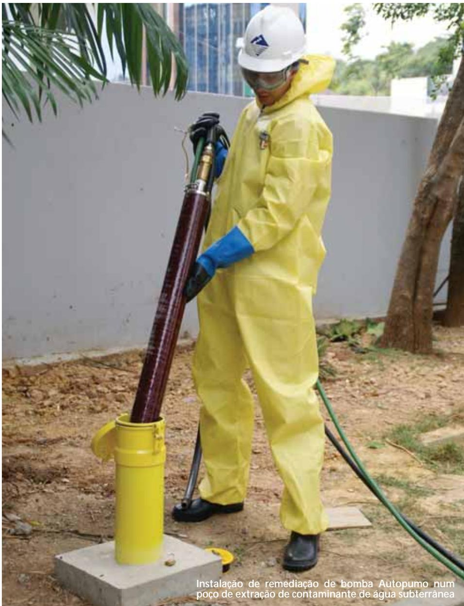
Instalação de remediação de bomba Autopumo num poço de extração de contaminante de água subterrânea
