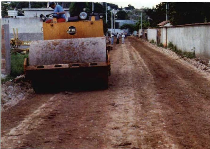
Figura 7. Pavimentação com reciclado em Belo Horizonte
