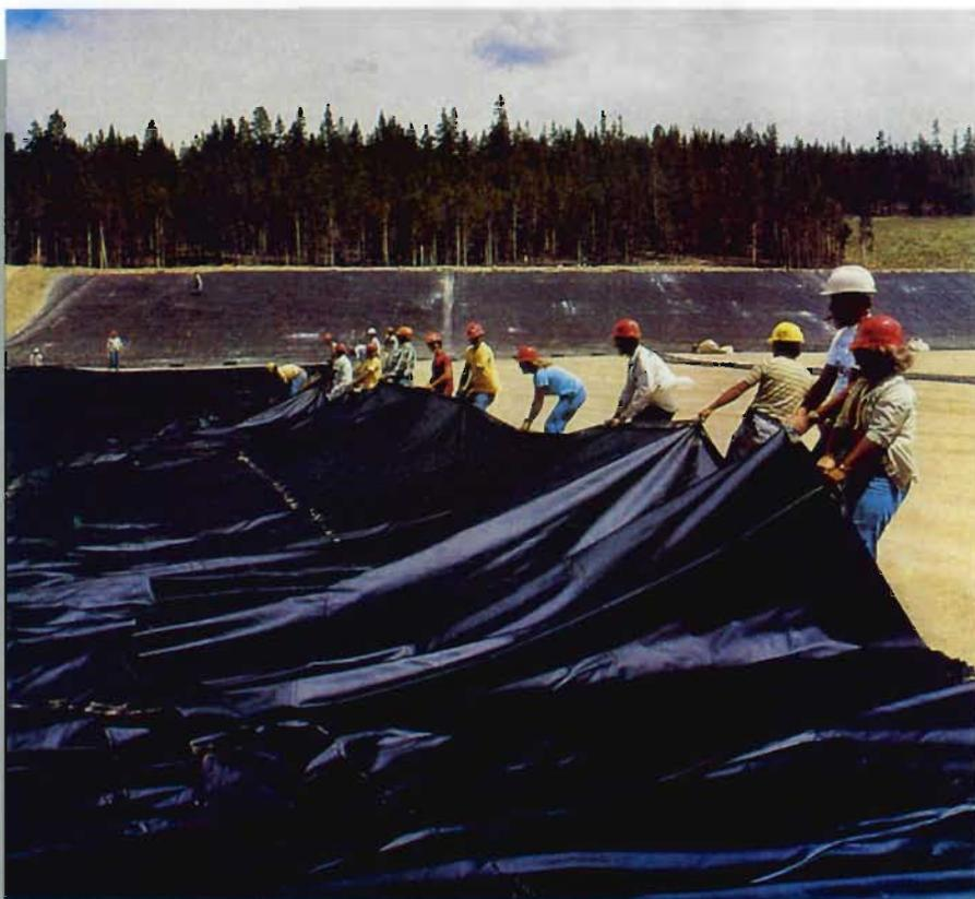
Figura 4. Colocação da manta plástica de PEAD para impermeabilização do aterro sanitário
