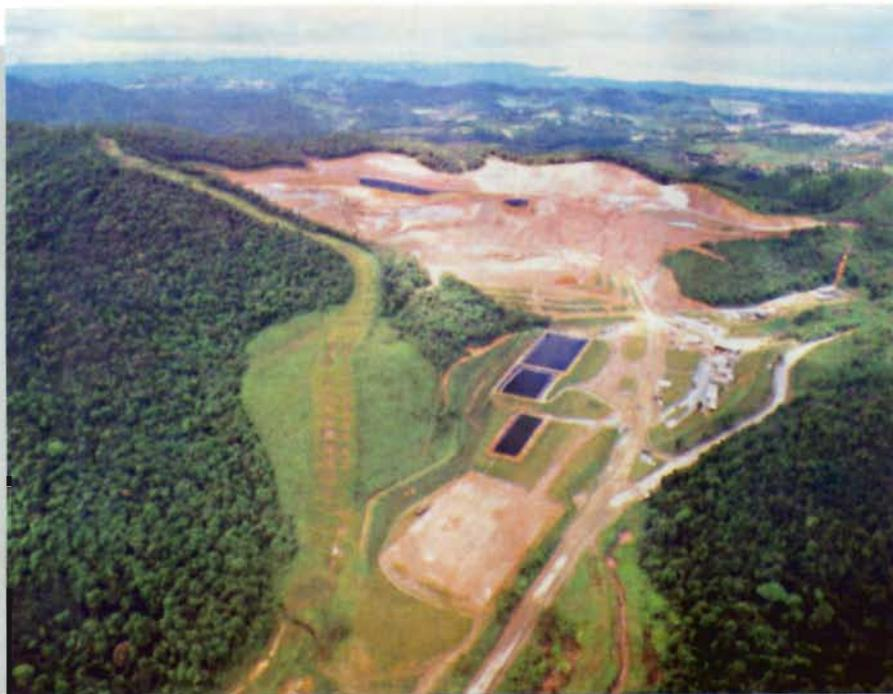
Figura 3. Aterro sanitário com lagoas para tratamento do efluente líquido.
