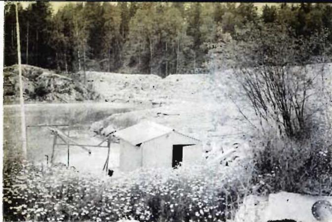
Aterro sanitário com recobrimento unicamente de lixo domiciliar triturado com adição de material fecal, vendo-se lagoa de estabilização de líquido percolado, que é em seguida tratado por flotação e cloração.
