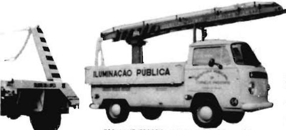
ESCADA TELESCÓPICA KABI AEHO-GIRUS tipo mecânica
