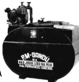
TANQUE ESTACIONÁRIO PARA ÁGUA "KABÍ" OPERADO POR POLI-GUINDASTES. CAP.: 3.000 LTS. COM MOTO-BOMBA PREF. MUN. DE GANDU - BA.
