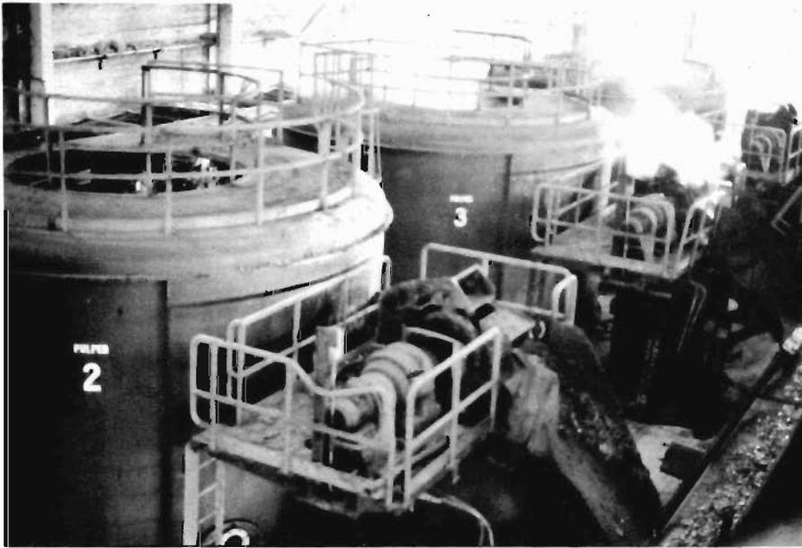
FOTO 4 – Hydropulpers (liquidificadores gigantes) aproveitados da indústria da celulose, para desintegrar lixo via úmida, na usina termoelétrica de 3.000 t/dia de Dade County, Flórida, 1983.
