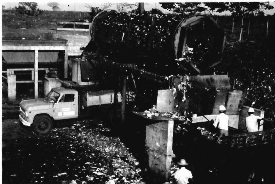
FOTO 13 - Peneira rotativa sextavada, desenvolvida pela CETESB para sua usina piloto sistema "natural" vendo-se no fundo o fosso receptor (chão move diço) a esteira de alimentação da peneira, caminhão para coleta de peneirados e carreta para rejeitos Novo Horizonte 1985.
