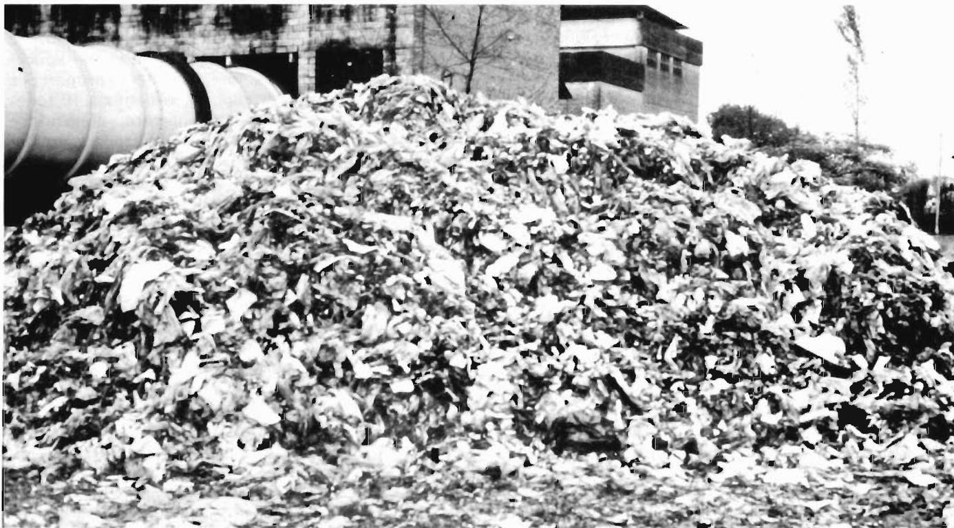
FOTO 22 - Rejeito ou refugo típico de usina de tratamento, cuja proporção chega a 50% da massa original, constituído predominantemente de plásticos em filme sujos e misturados, e que deve ser transportado e disposto de aterros. Vila Leopoldina, 1983.
