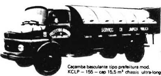
Caçamba basculante tipo prefeitura mod. KCLP - 155 - cap 15,5 m<sup>3</sup> chassis ultra-longo
