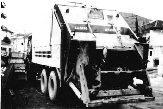
*Container sendo acoplado ao dispositivo hidráulico para basculamento*
