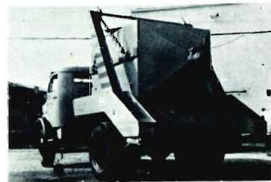
As Indústrias Mecânicas Kabi também fabricam as caçambas estacionárias especiais, que são próprias para transporte de combustível e são operadas pelos poliguindastes do mesmo sistema "Multibend". A foto acima mostra uma caçamba.
