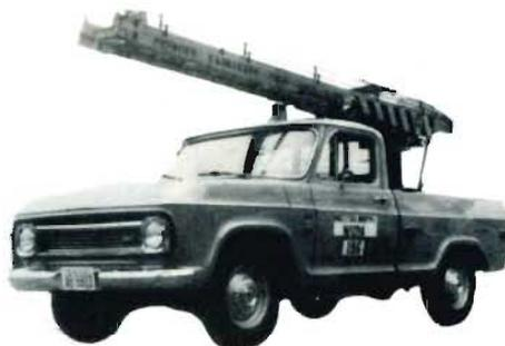
Escada telescópica KABI-AEROGIRUS acoplável em pick-up. Giro de 360° e para trabalhos de até 10 m de altura. Apresentadas em 2 modelos: mecânica e hidráulica.
